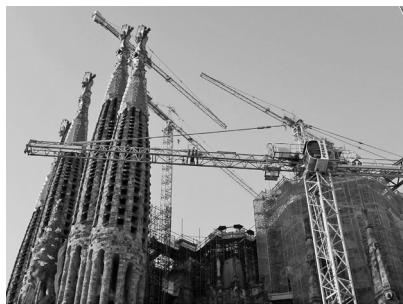
写真10 工事中のサグラダ・ファミリア教会
